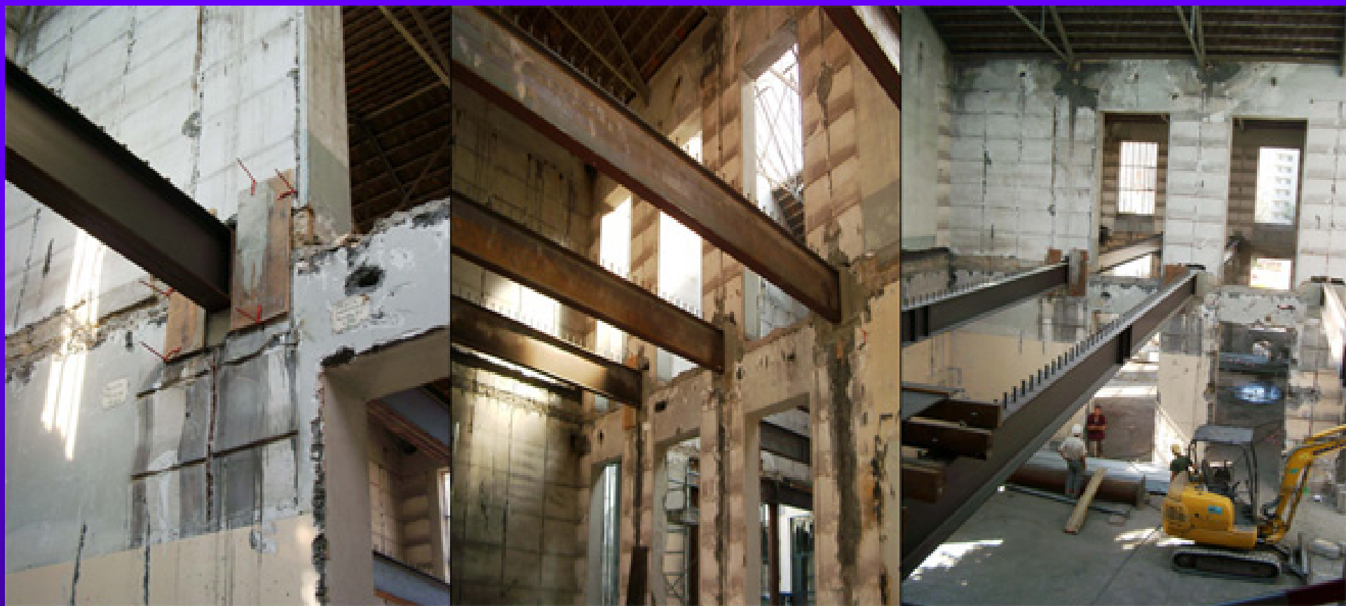
Vigas mixtas que atraviesan el muro de soporte
